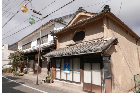
袖壁を持つ町家
